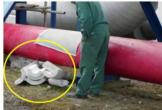
二つ割りのケイカル系石綿保温材。非常に軽く断熱性に優れていますが、もろくて発散しやすいのが欠点。放置すれば自然劣化により飛散し、敷地を往来する労働者がばく露する可能性があります。
