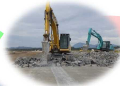
①舗装版の撤去
