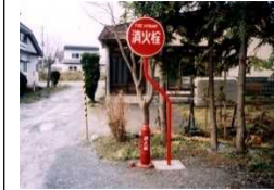
消防施設（消火栓）
