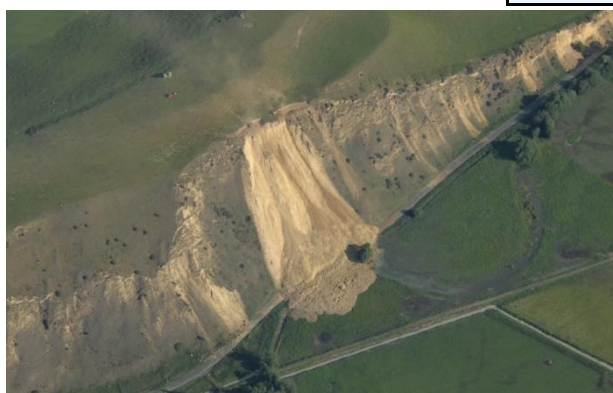
被災状況の確認(崖崩れによる道路寸断)
