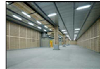
【冷凍冷蔵施設（内観）】
