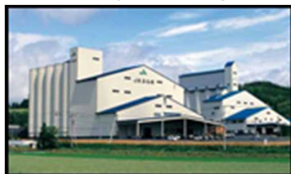
【乾燥調整貯蔵施設】
