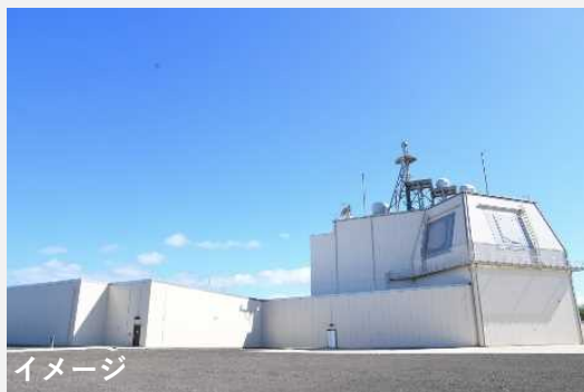
レーダー施設
