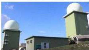
FPS-7（宮古島分屯基地）
