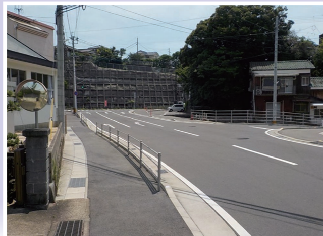
【相浦駐屯地】道路改修(椎木大潟町線・長崎県佐世保市) 補助額：約8億円
