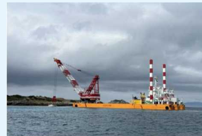
基礎捨石工事
