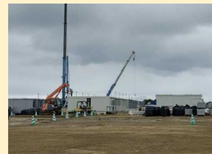
仮設宿舎工事
