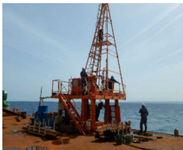
▲ボーリング調査の様子
