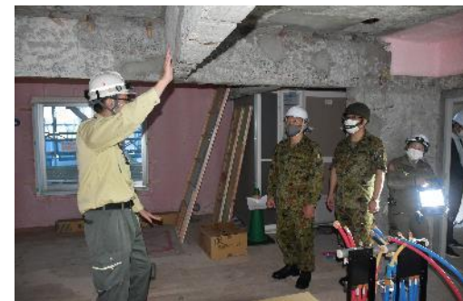
改修工事中宿舍内の巡視
