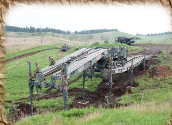
自走架柱橋架設
