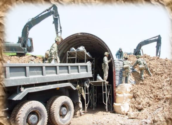
掩体・掩壕構築
