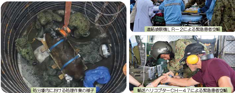
処分場内における処理作業の様子
