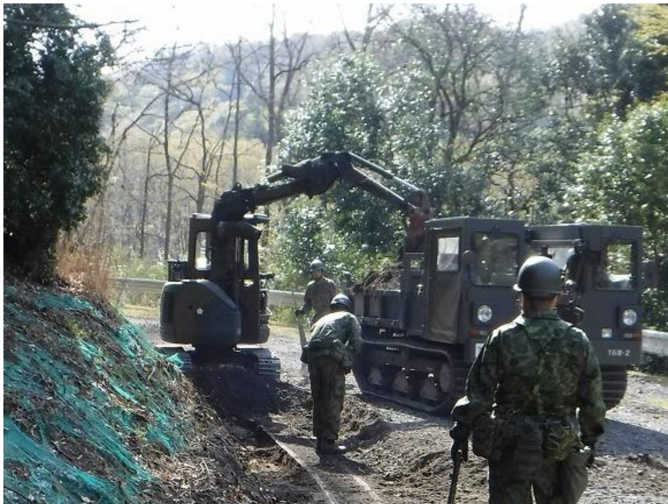
重機を使用した側溝整備
