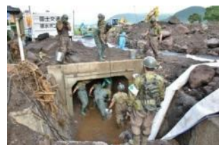
災害派遣 (北部九州豪雨災害)
