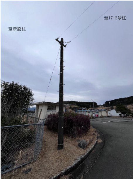
④ 17-3号柱 装柱状況写真
