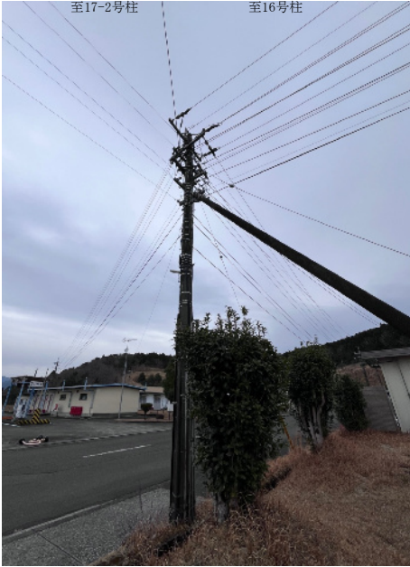
② 17号柱 装柱状況写真
