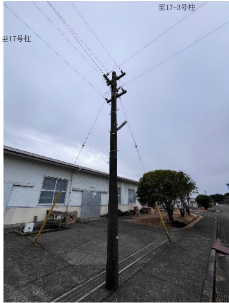
③ 17-2号柱 装柱状況写真
