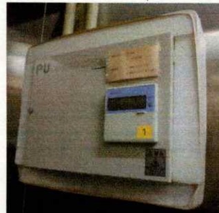
施工場所③予冷库 コントローラー交換
