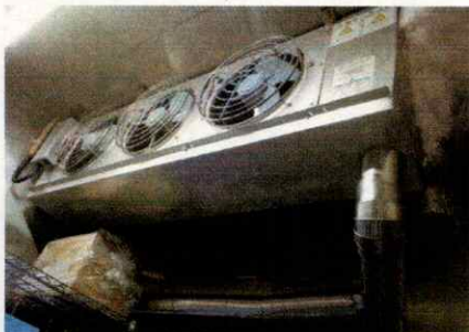
施工場所②冷凍庫 室内機交換
