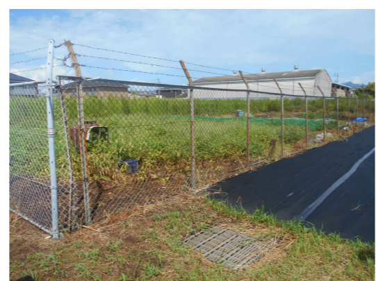
施工場所現況写真①
