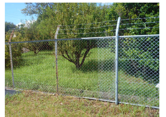
施工場所現況写真③
