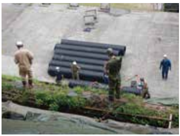
配管運搬状況
