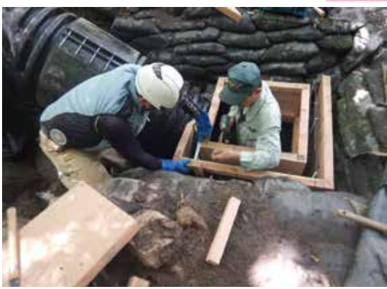
流末部のコンクリート打設作業状況
