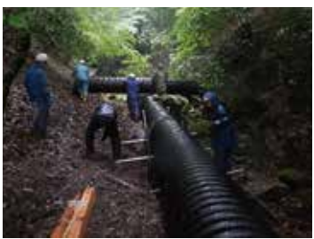
配管運搬・接続固定の様子
