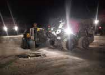
滑走路被害復旧中の隊員
