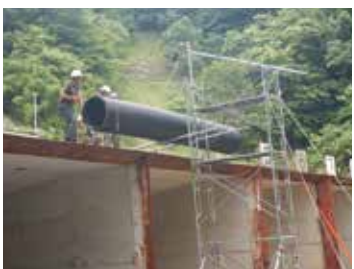
配管運搬状況
