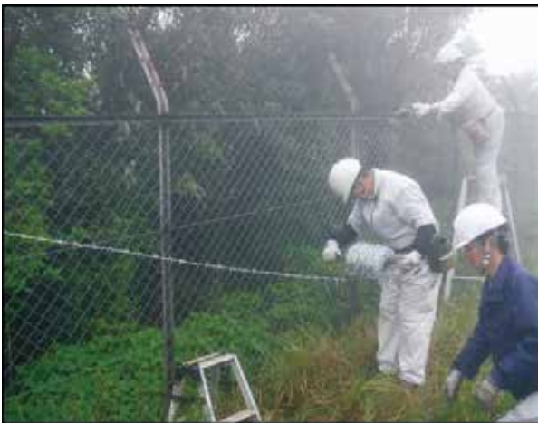
外柵補修を実施する管理科隊員
