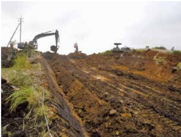
少ない勢力での工事です
