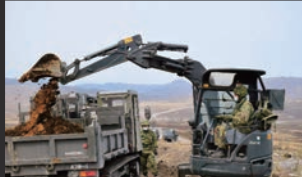
4/9~16 日出生台定期整備
