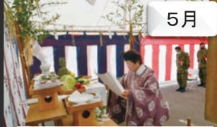
5/12 隊舎建替え工事(地鎮祭)
