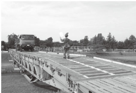
西方唯一の パネル橋MGB (橋架梁設)
