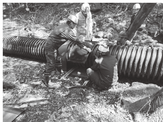
桜谷射撃場排水管整備
