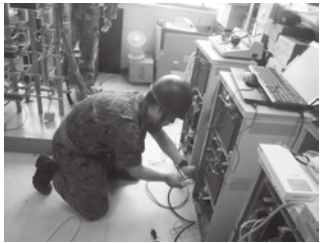
通信器材の開設
