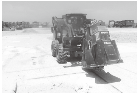
滑走路被弾箇所 の切断 (陸自ホイソウ)
