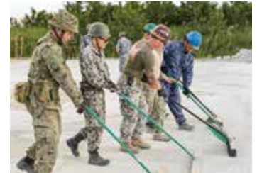
沖縄での滑走路応急復旧 (海自、空自、米軍とともに実施)
