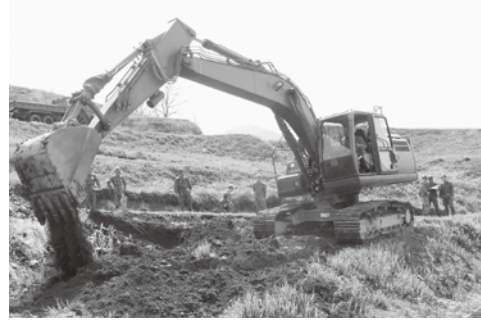
暗渠設置のため掘開作業
