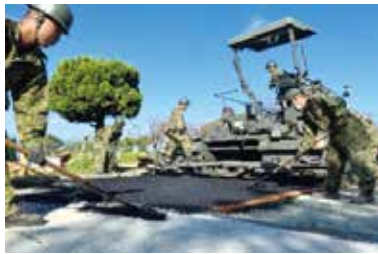
「道」(アスファルトの敷き均し)
