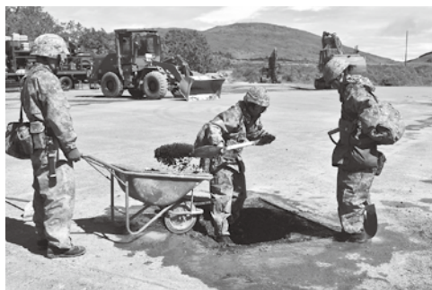
滑走路の応急復旧作業
