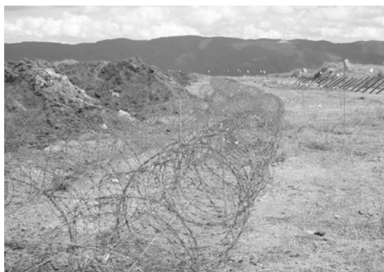
完成した汀線部障害
