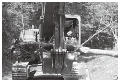
障害となる木の除去
