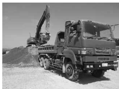
骨材積載 ~重機との連携作業~
