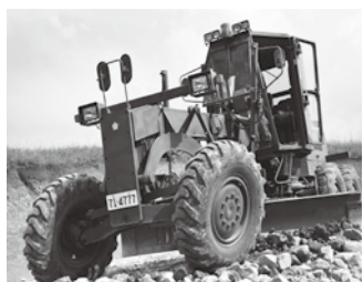
新中須道拡幅整備
