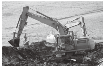
新たな射撃陣地の造成整備
