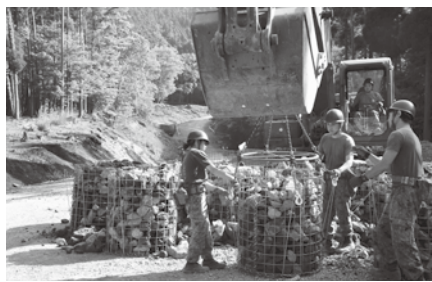
荒廃箇所整備 (南道)
