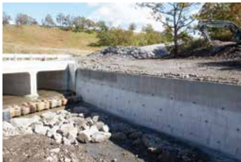
河川補修工事【かえで橋（仮称）】
