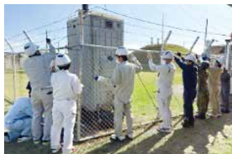
損傷したフェンスの復旧作業
