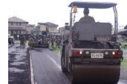
アスファルトオーバレイ舗装 (特殊器材中隊)
