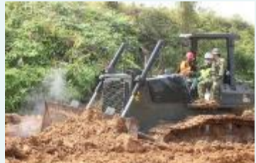
基本作業実習訓練（ドーザ）
