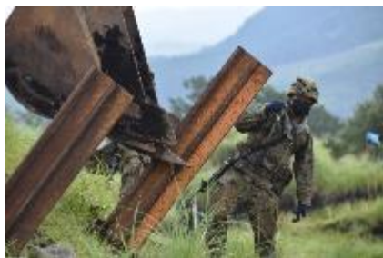
対舟艇杭の打設 (第401施設中隊)
