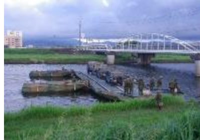
9 2式浮橋による門橋の構築・運航 (架橋中隊)
