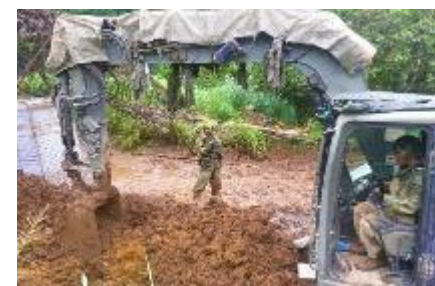
降雨の中掘削作業を実施する隊員
