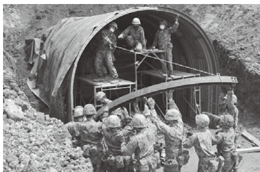
車両用掩蓋壕の構築 (架橋中隊)
