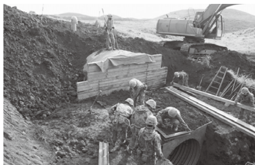
指揮所用掩蓋壕の構築 (特殊器材中隊)
