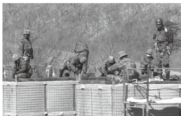
設置型土のう構築中の隊員
