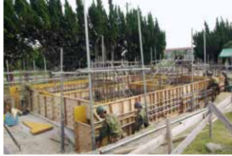
基礎配筋・型枠設置
