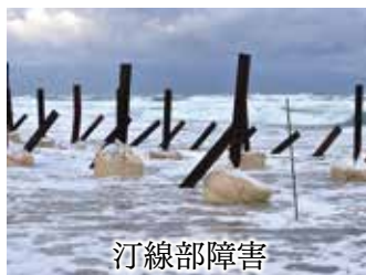
1t土嚢を用いた障害
