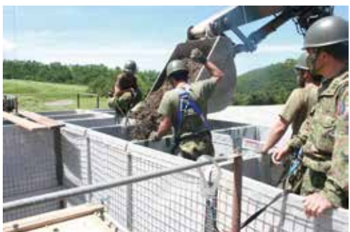
ソイルアーマーを使用した陣地構築
