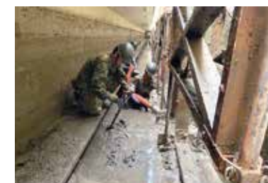
監視壕へ流入した土砂の除去
