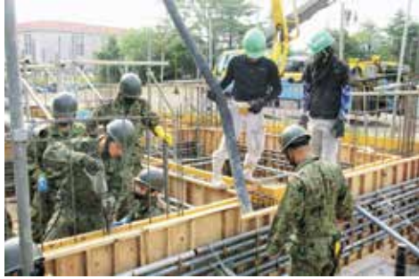
コンクリート打設
