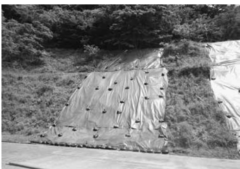
法面保護シートの張替え
