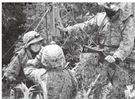
アンテナ建柱（通信班）
