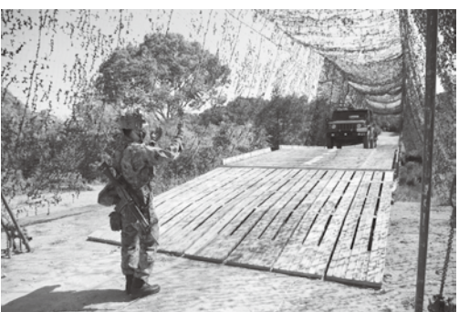
パネル橋MGB架設完了
