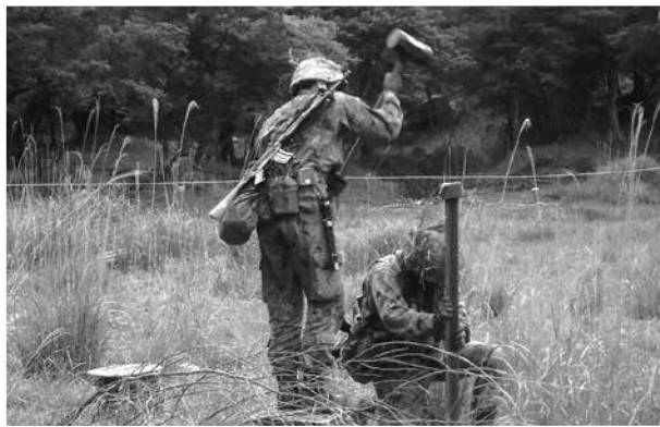
対空挺ヘリボン障害構成の植杭作業
