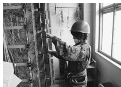
直通回線構成配線作業
