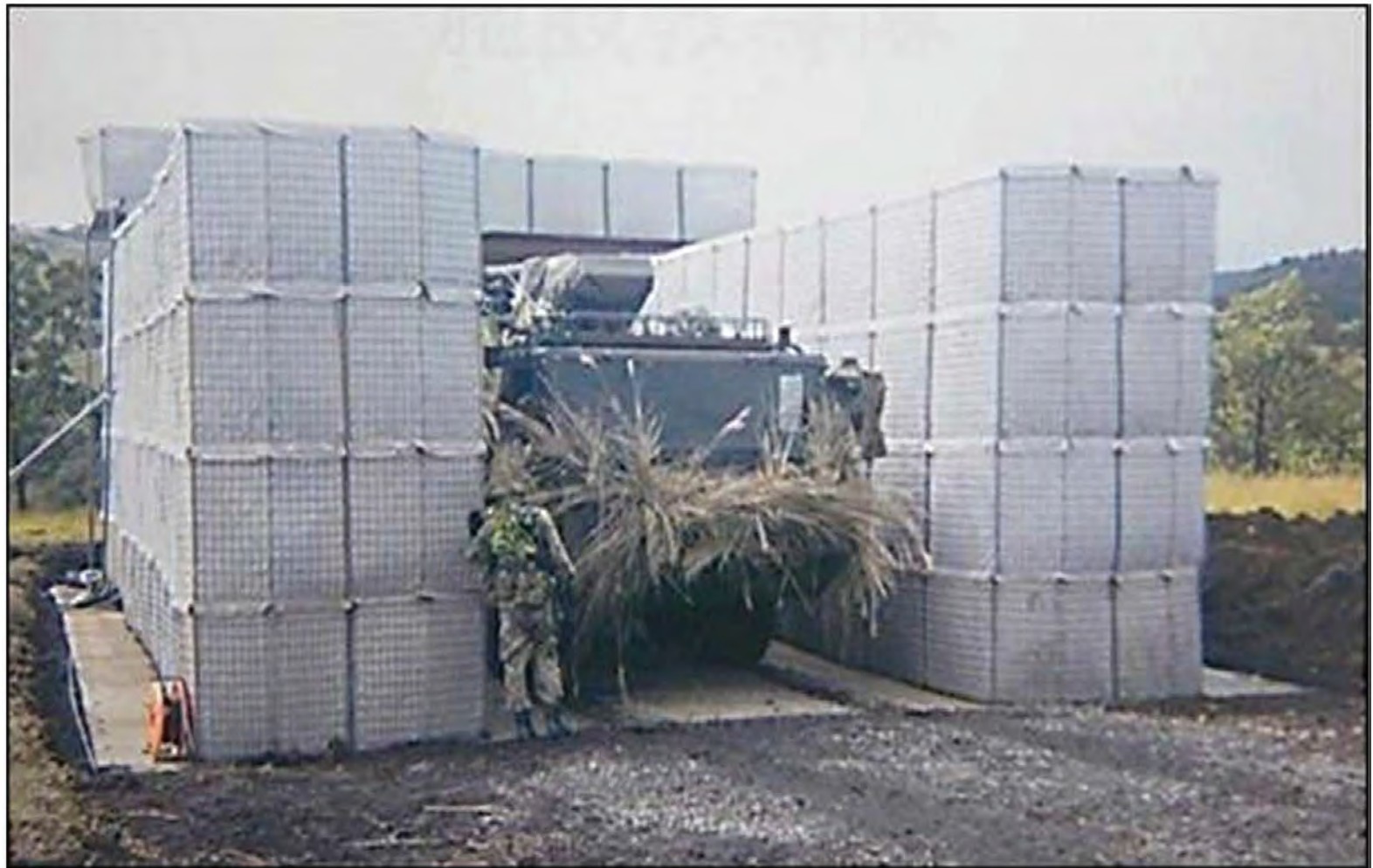
地上設置型掩体の構築
