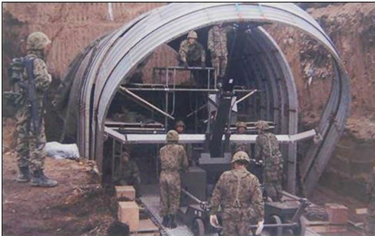
LPビルダーによるライナープレートの構築
