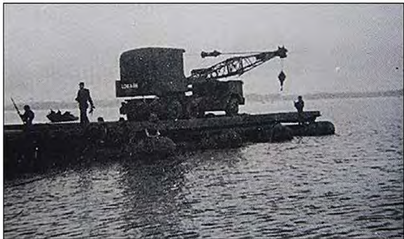
重門橋へのクレーンの搭載
