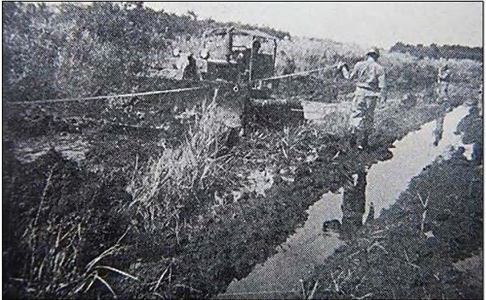
湿地ドーザによる泥ねい地の通過試験
