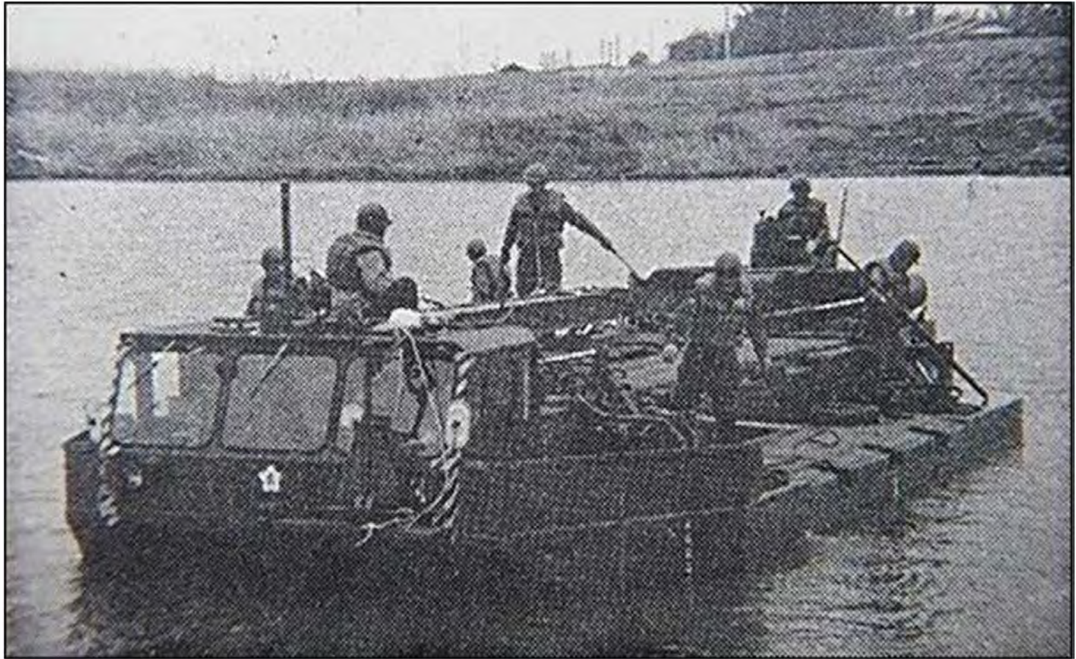
70式自走浮橋による河川の航行
