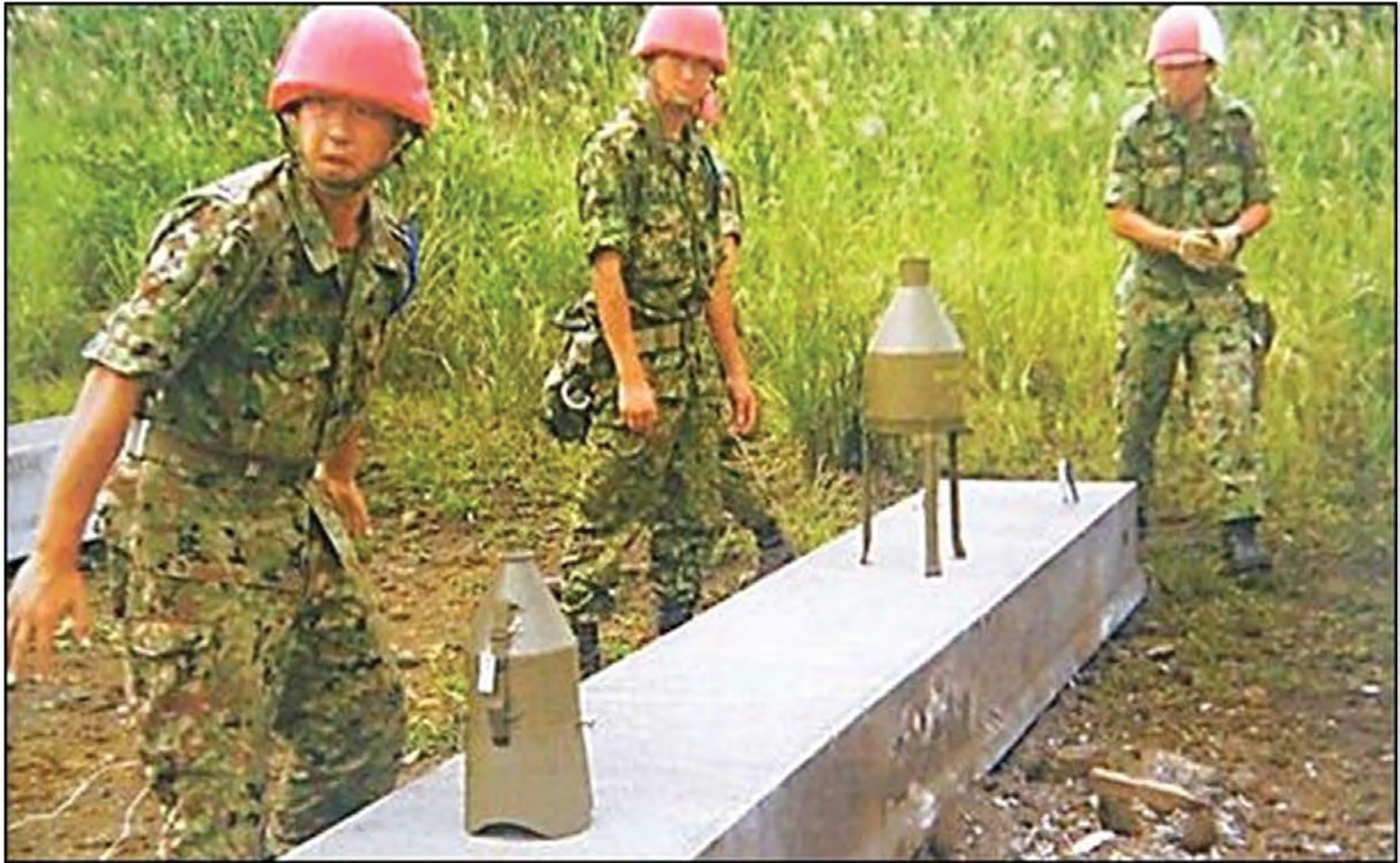
指向性爆破薬による鉄筋コンクリートの破壊
