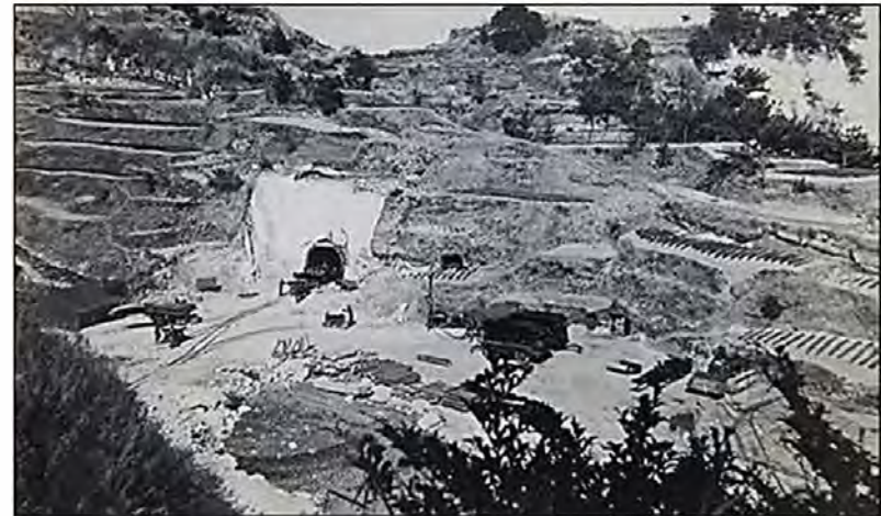
坑道掘削現場の景況
