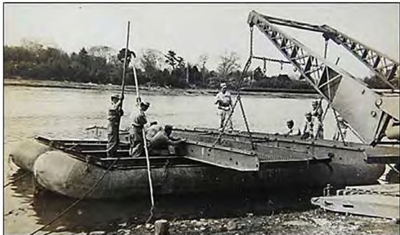
重門橋の構築
