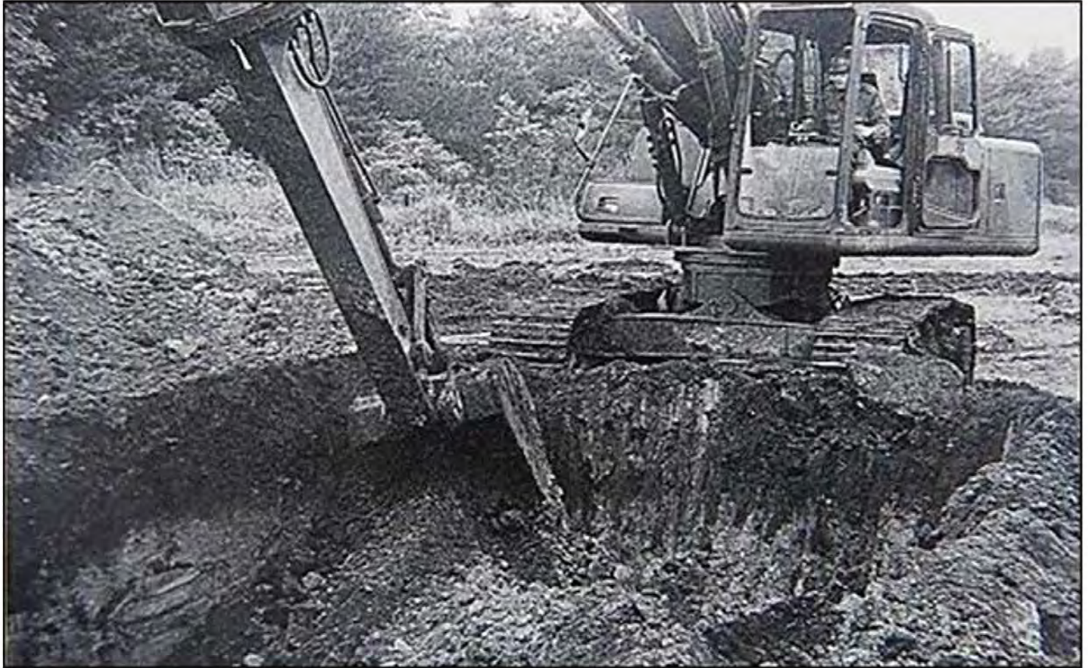
掩体掘削機による地面の掘開
