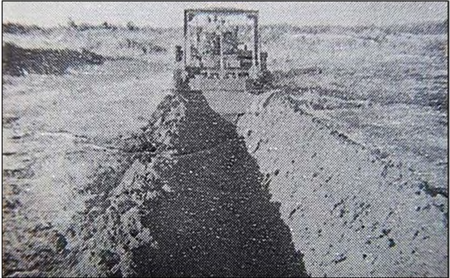
対戦車壕を掘削する築城用壕掘機
