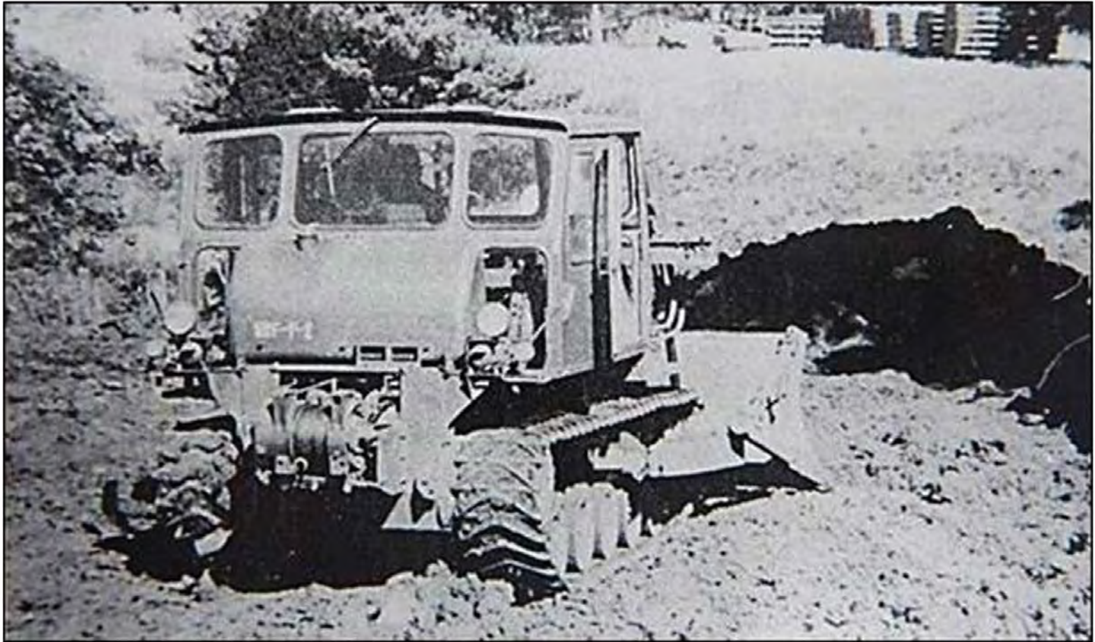
75式ドーザによる押土作業
