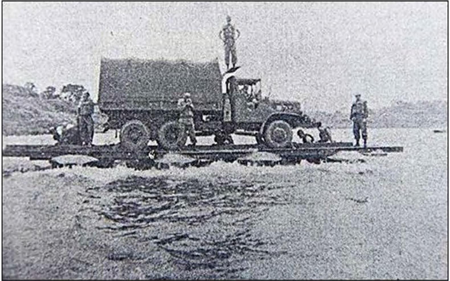
アルミ導板を使用した軽門橋の航行
