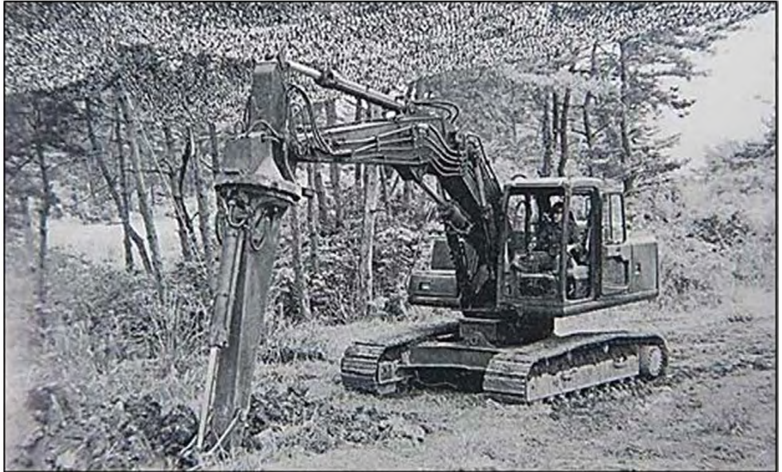
掩体掘削機による地面の掘開
