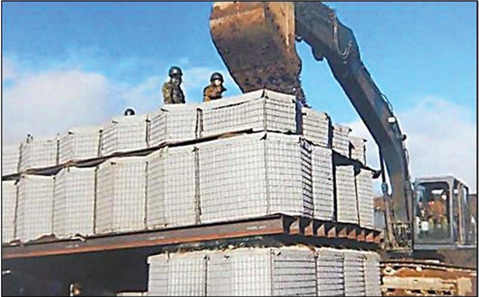
地上設置型掩体の構築
