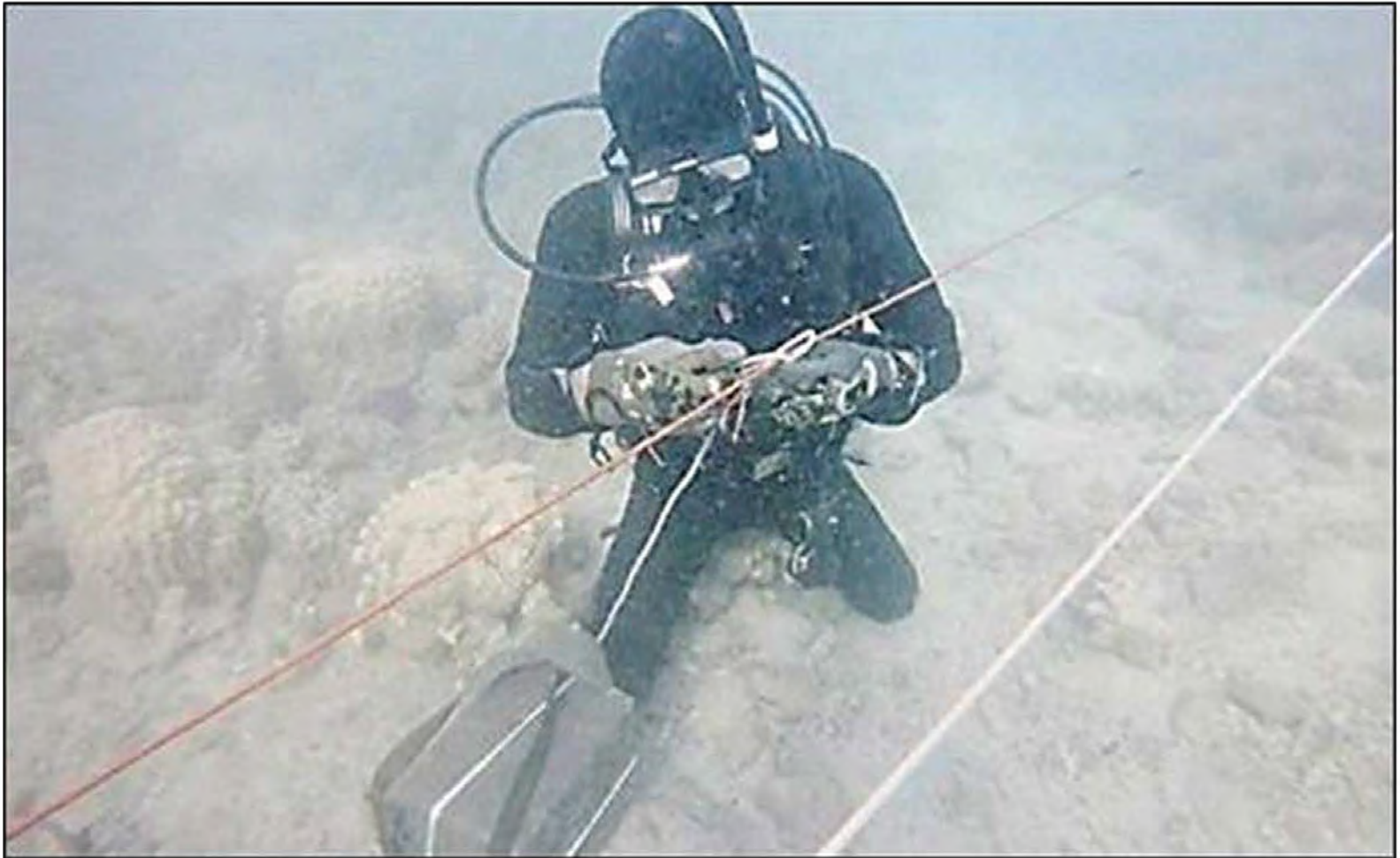
水中で爆破回路を構成するダイバー
