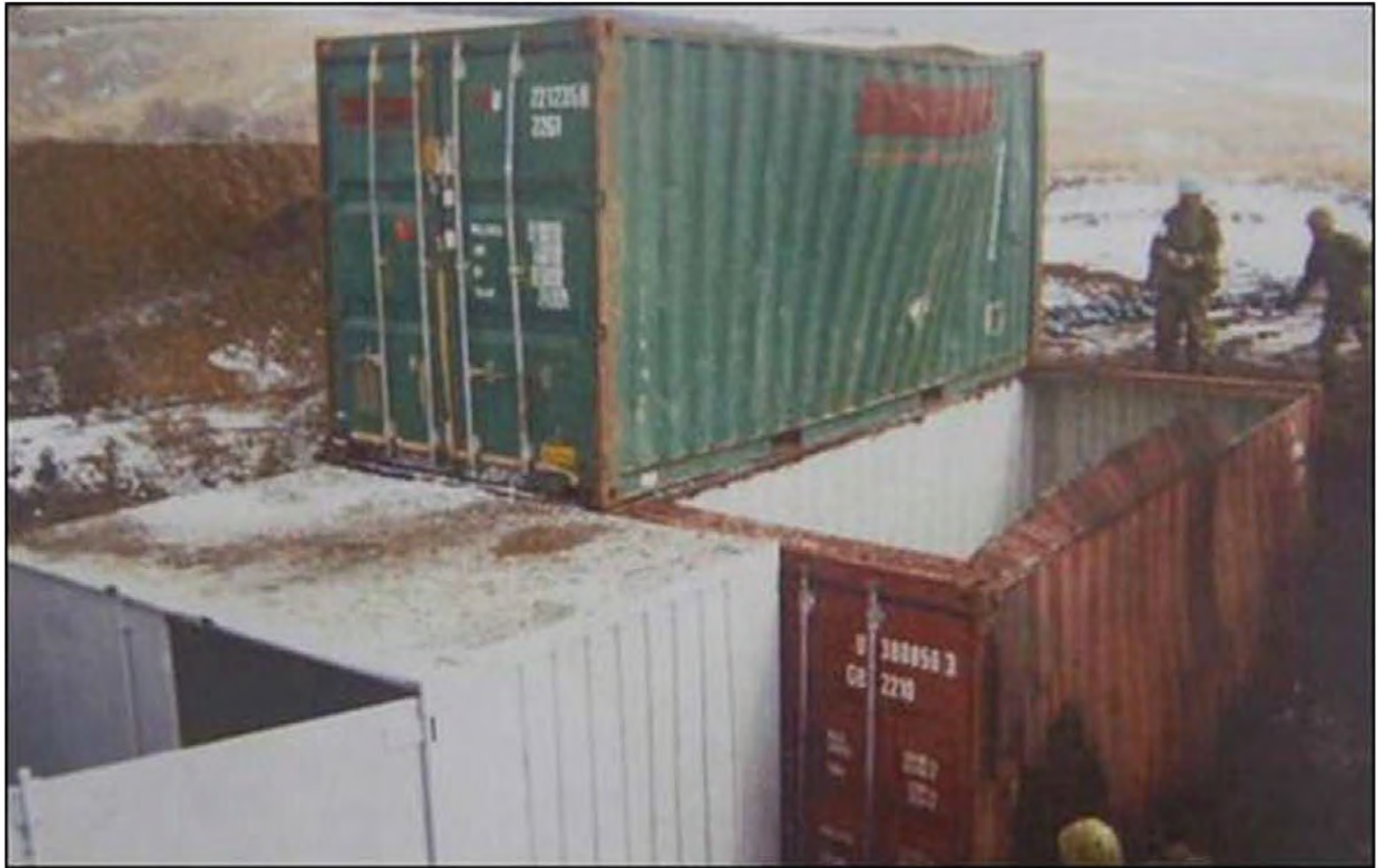
コンテナを利用した築城の検証
