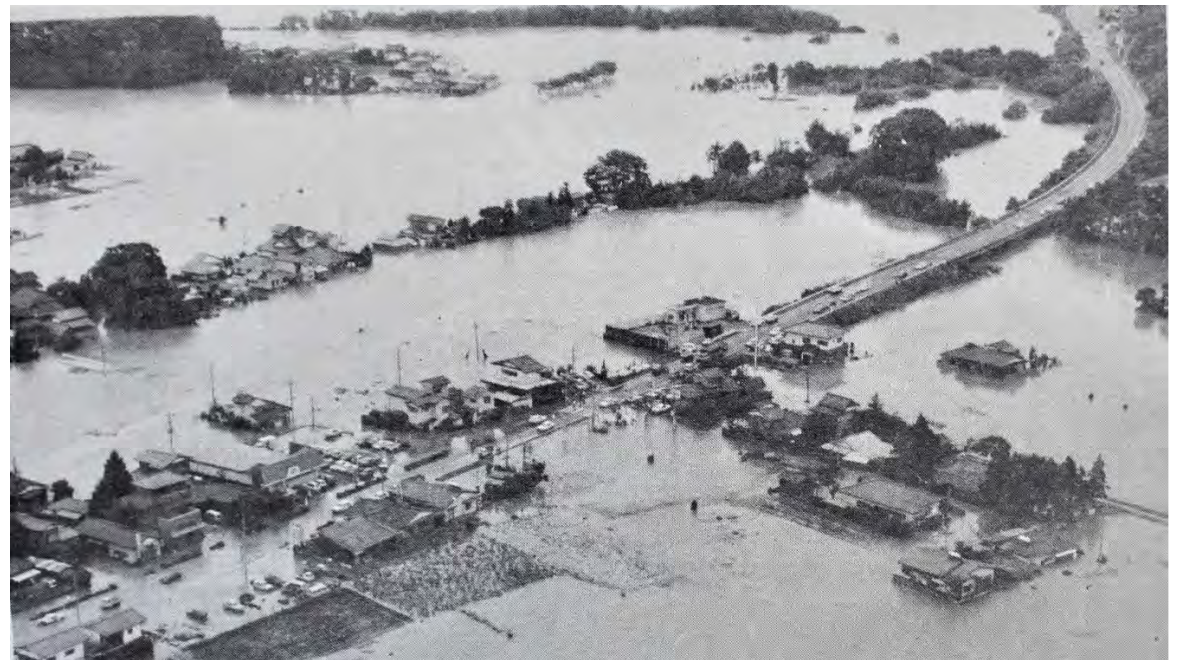
那珂川の増水で寸断された国道123号
