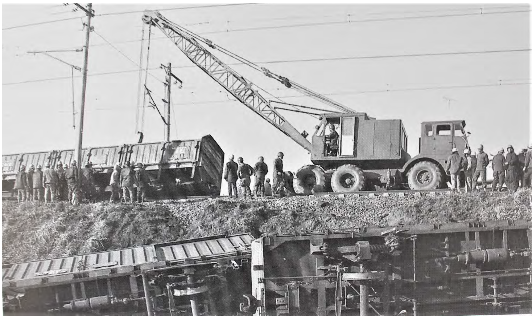
勝田駐屯地のクレーンを使用して線路から脱線転落した車両の引揚を実施
