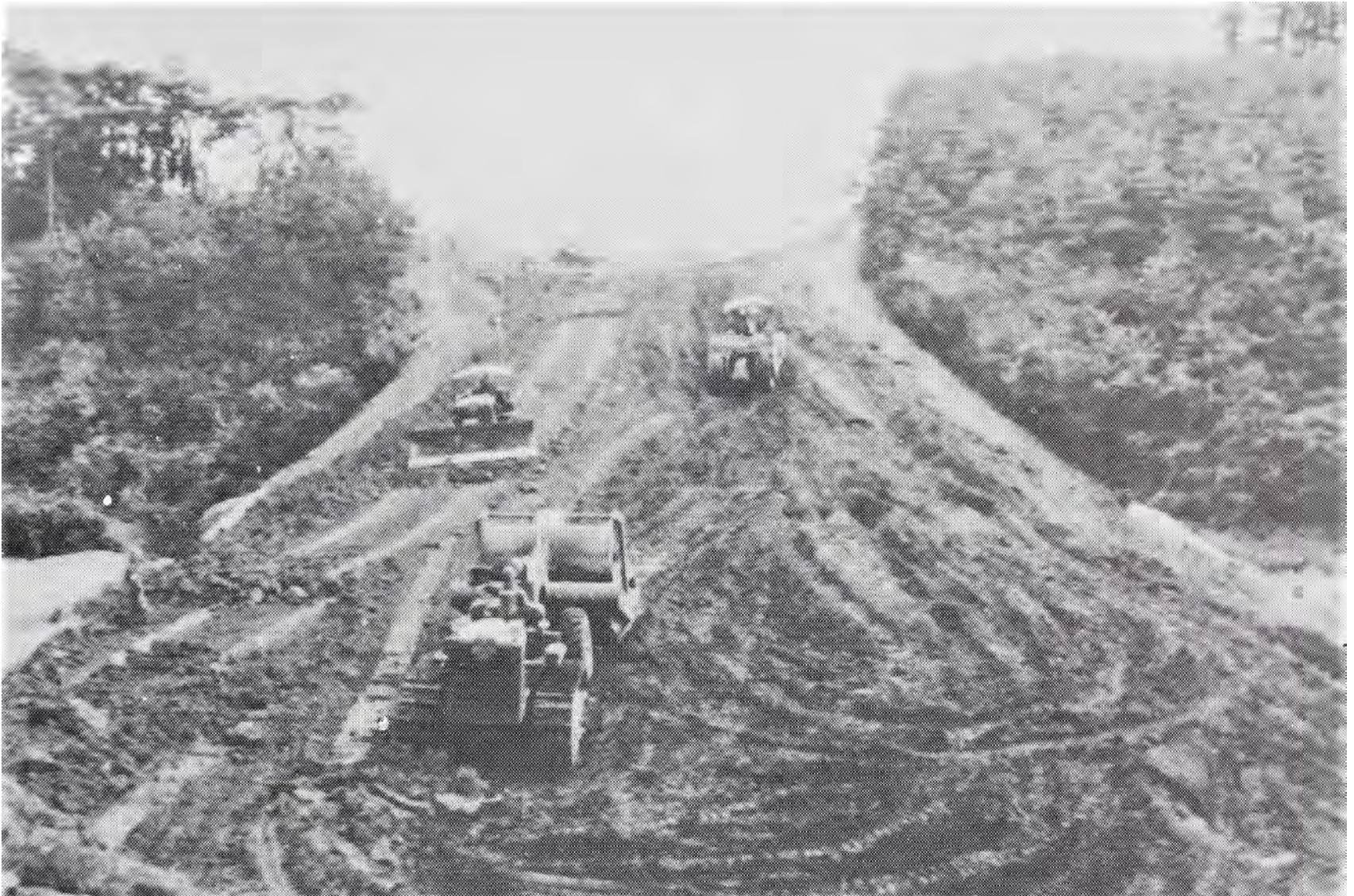
ドーザにより道路を整地中の施設教導隊
