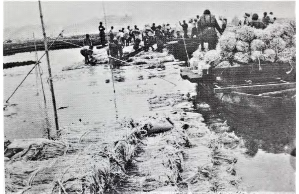
俵に土を入れた土嚢を水中に投入し応急道路を構築
