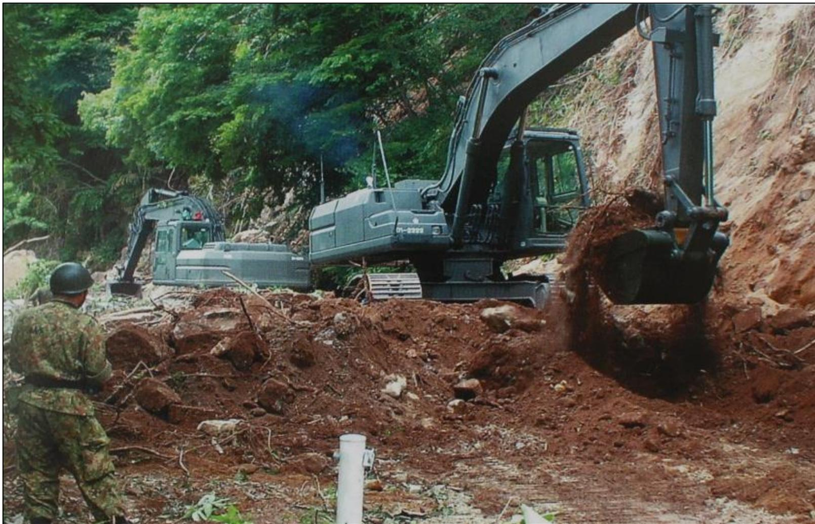
土砂崩れで寸断された道路をリモコン式油圧ショベルで復旧する施設教導隊
