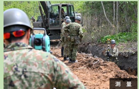
モニター情報をもとに器材操作 (マシンガイダンス)
