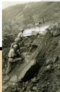
⑫昭和40年度 志津～月山線造成工事
