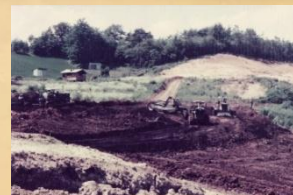
③昭和51年度 岩手町沼宮内高校敷地造成工事
