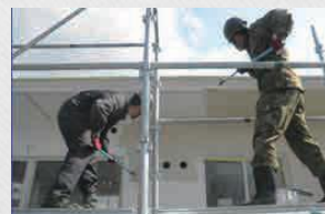
⑮平成24年度 船岡門分哨建替工事
