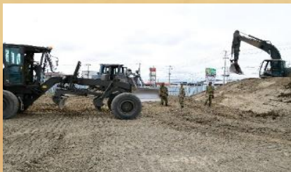
①令和2年度 柴田町防災拠点総合体育館敷地造成工事
