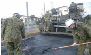
②平成30年度 多賀城駐屯地道路舗装工事
