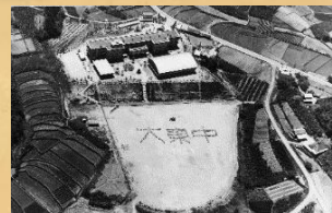
③昭和45年度 大東町総合グランド敷地造成工事
