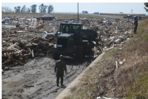
宮城県名取大橋 西側道路
