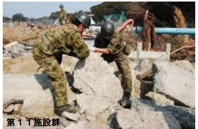
道路上の瓦礫の除去（桂島）
