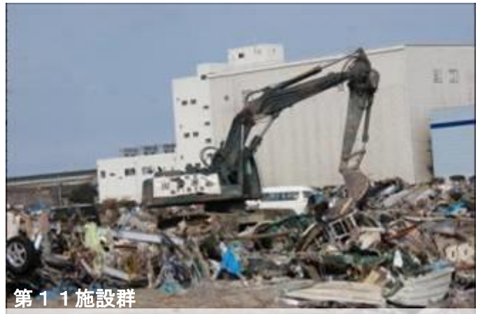
仙台市宮城野区（蒲生地区）での道路啓開
