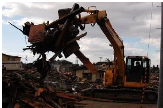
権道98号線の道路啓開(女川町)
