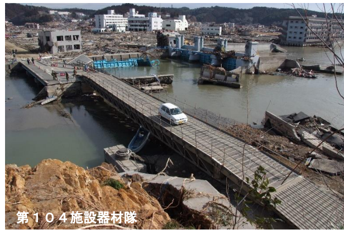
第104施設器材隊 国道45号に架けられたパネル橋MGB (南三陸町志津川地区)
