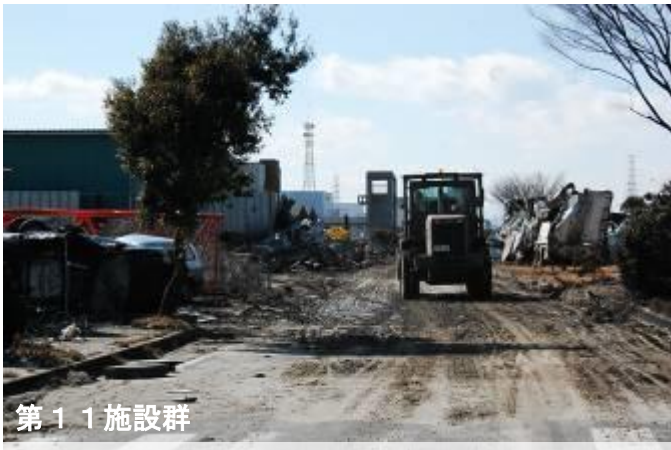
仙台港周辺の道路啓開
