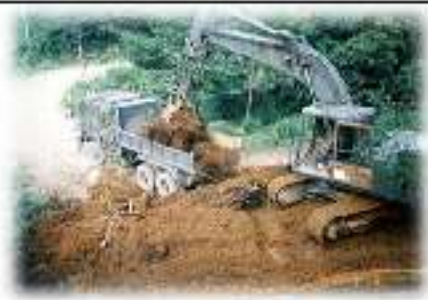
各種造成工事
