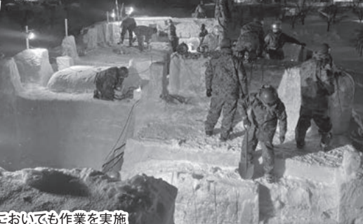
夜間においても作業を実施
