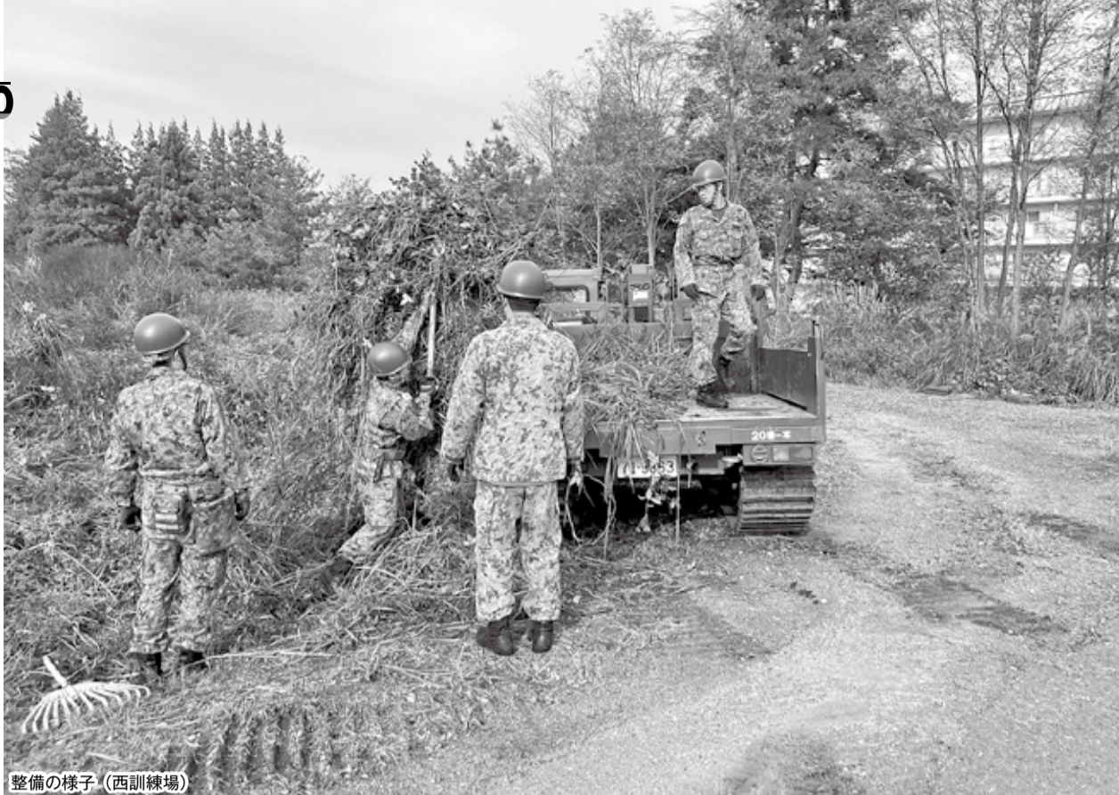
整備の様子（西訓練場）
