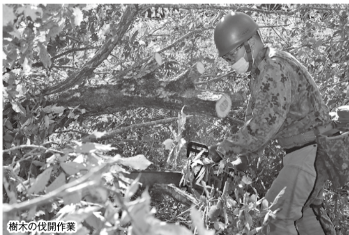
樹木の伐開作業
