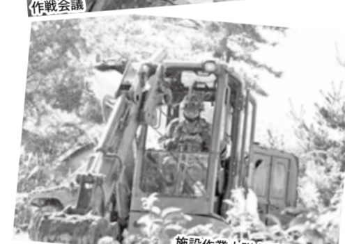
施設作業小隊が重機を運用
