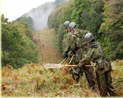
急斜面も整備
