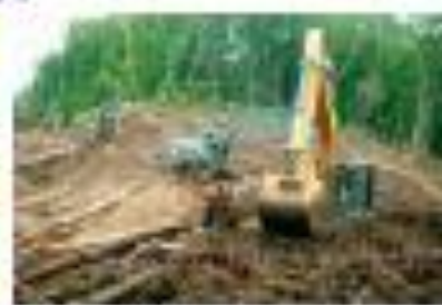
災害派遣（北海道庁 板敷地区）
