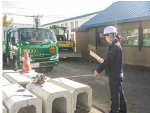
工事の監督：丘珠駐屯地業務隊
