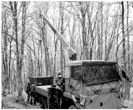
シェルター卸下作業
