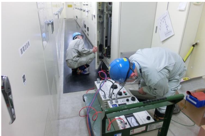
病院施設の点検
