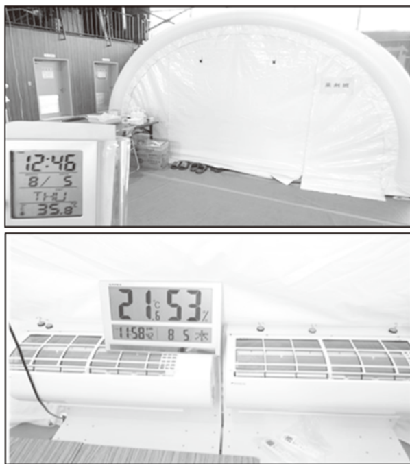
図4 感染症対策用陰圧式エアテントシステムの準備室テント
