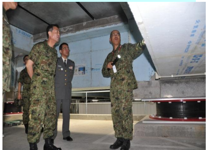
施設研修(免震層)
